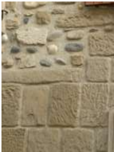
Façade en galets qui doit être enduite
