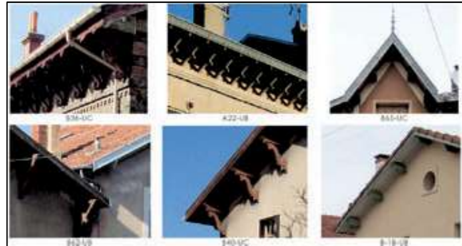
Exemple de passées de toit à Bourg-Lès-Valence
