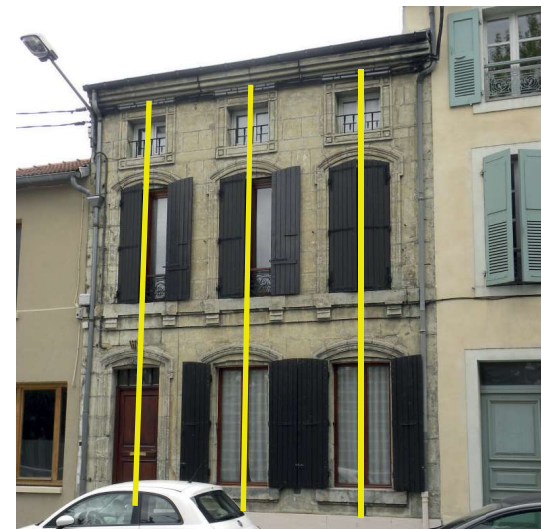
Façade ordonnancée : ouvertures axées
