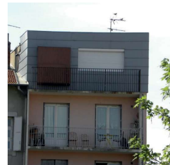
Surélévation peu cohérente avec l'existant et dont le parti pris qui se voulait contemporain n'est pas allé au bout de la démarche.
