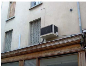
Interdits : les climatiseurs en applique. Les volets battants en bois sont très utiles pour tempérer l'intérieur en été, d'où l'intérêt de les conserver
