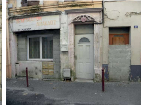
Il est interdit de maçonner une ouverture pour installer une fenêtre standard
