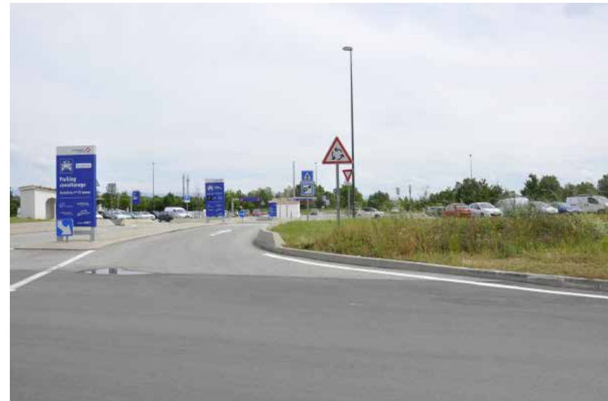
Aire de covoiturage Vinci à Bourg-Lès-Valence
