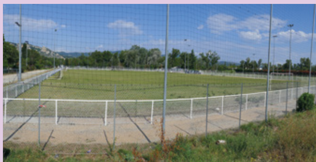
Juillet - Réalisation de nouveaux aménagements au stade de football de l'Île-Parc Girodet
