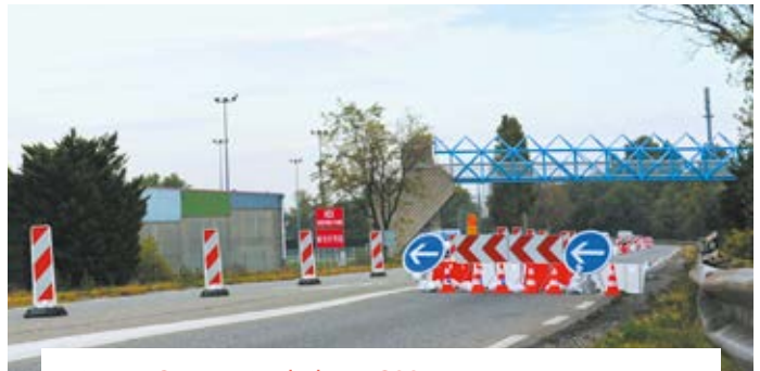
Mise en 2 x 1 voie de la RD2007N pour aménager le futur tracé et le nouveau parkway.
