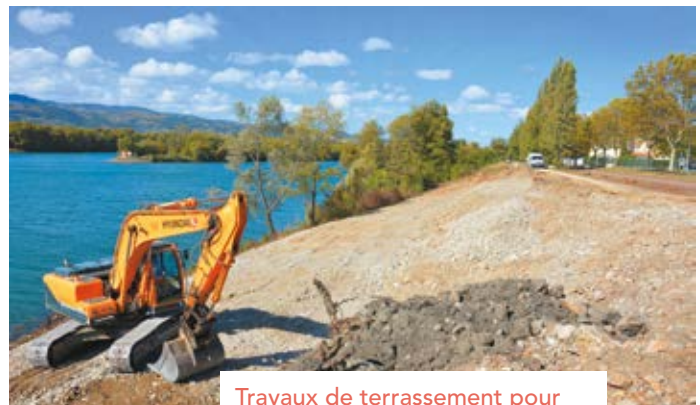
Travaux de terrassement pour l'aménagement de l'esplanade.
