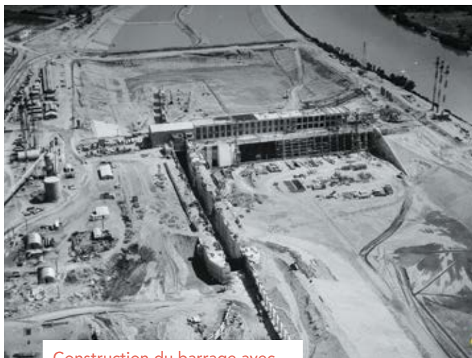
Construction du barrage avec au premier plan l'écluse en cours de réalisation.
