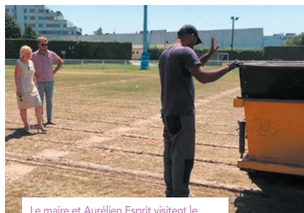
Le maire et Aurélien Esprit visitent le chantier de drainage du terrain de rugby.
