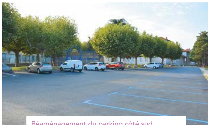
Réaménagement du parking côté sud de l'école Barthelon.
