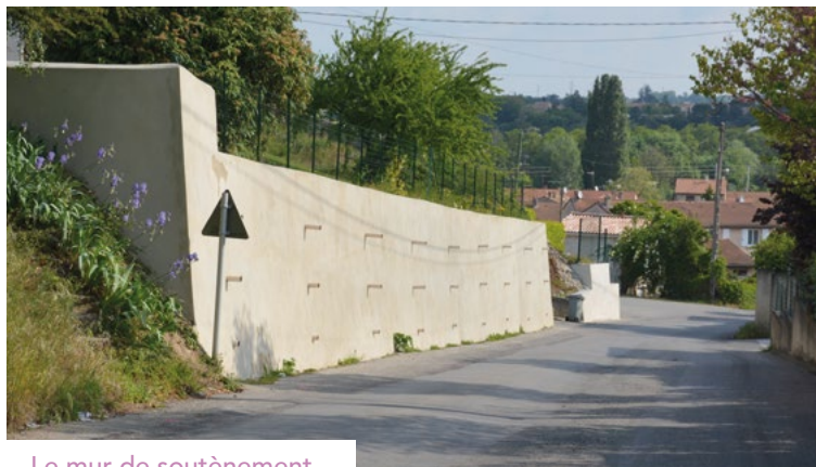
Le mur de soutènement
